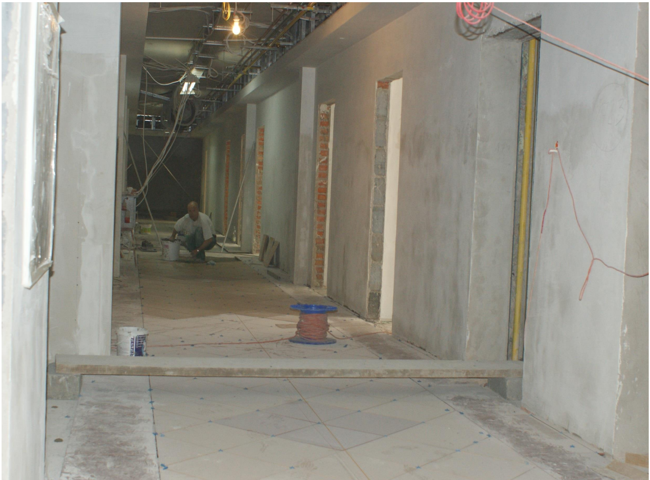
Widok z holu głównego na korytarz Prowadzący do Dzekanatu
