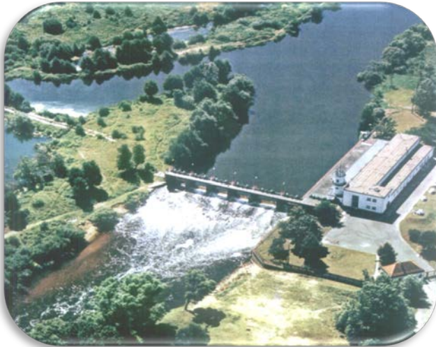
Ujęcie wody na Pilicy w Tomaszowie Maz.
